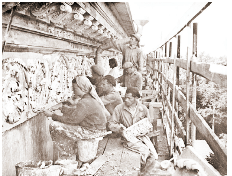
Идут реставрационные работы
