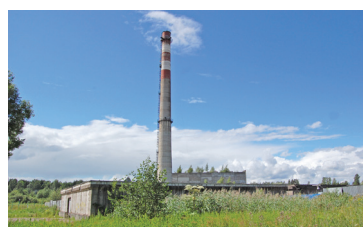
Котельная у железной дороги
