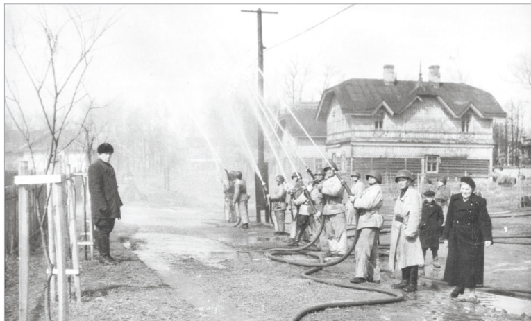
Тренировка пожарных на улице 1-го Мая (справа видны два дома на участке А.Д. и К.Т. Ивановых со стороны улицы 1-го Мая в районе левого крыла современного дома № 6). Фото 1946 года
