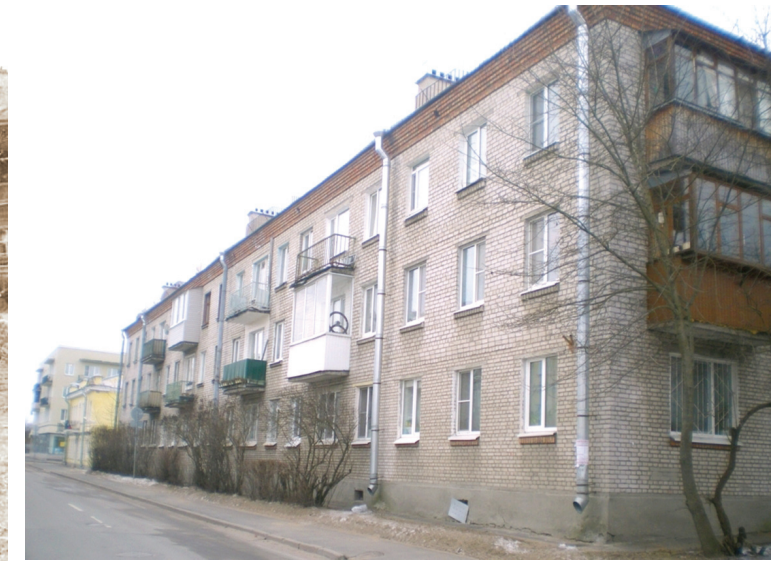
Современный дом по адресу: улица Госпитальная, 15
