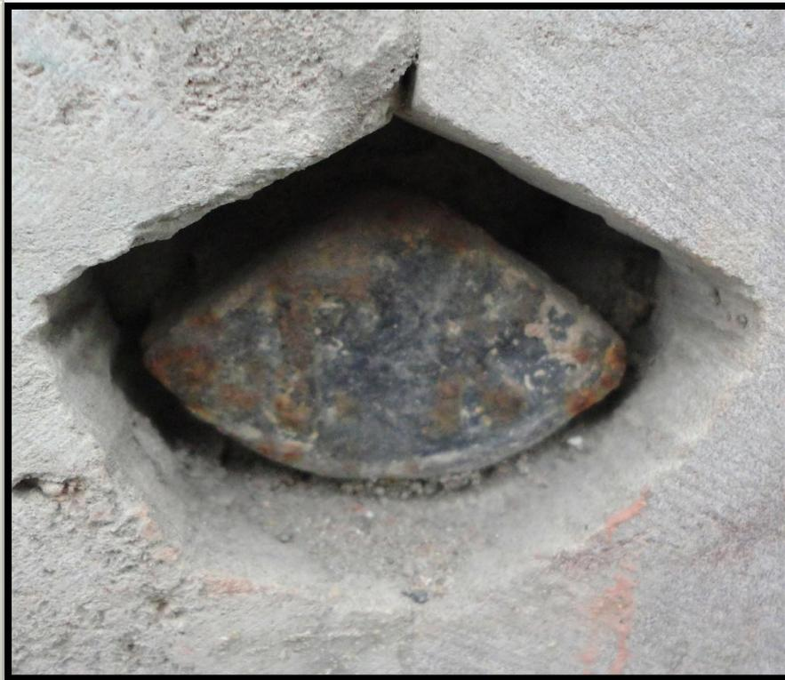
**При проведении фасадных работ стенной репер оказался «замурованным» в фундаменте здания. Выполнение геодезических работ невозможно.**
