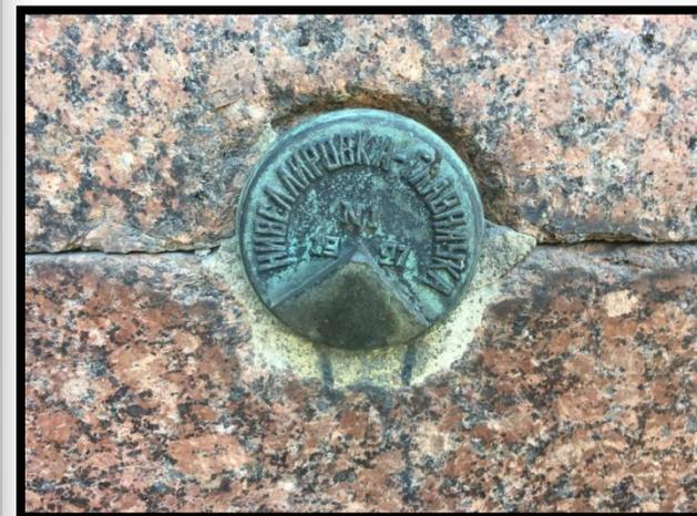
**Стенная марка, предназначенная для наблюдений за высотными деформациями Исаакиевского собора.**
