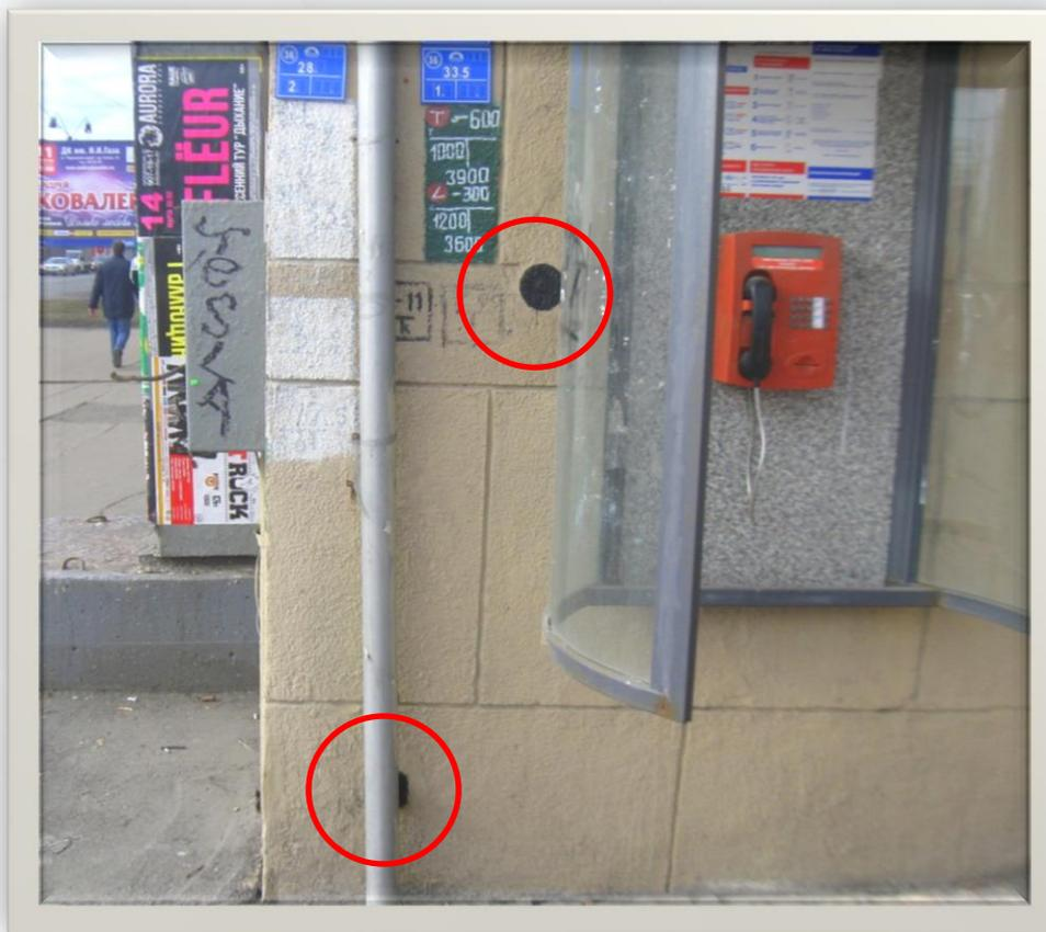
Из-за кабеля, проложенного в трубе, затруднен доступ к стенному реперу, а телефонная будка рядом со стенной маркой может усложнить выполнение геодезических работ.
