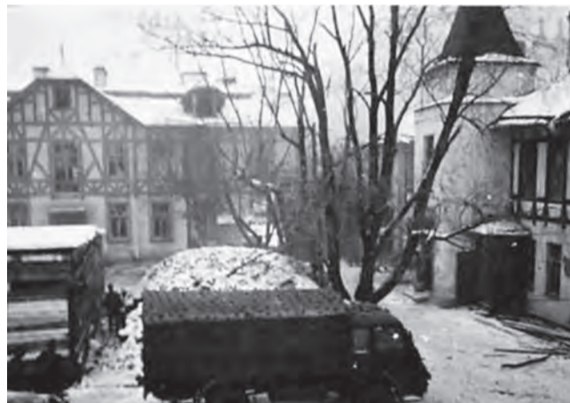
Дома Е. Я. Евдокимовой. Фото со стороны Конюшен. Справа — фасад углового дома с выступающей башней с шатровой крышей (со стороны двора), слева — навес, примыкающий к «Дому с башенкой», на заднем плане — двухэтажный каменный флигель с мансардами, холм за автомобилем с кузовом под тентом — ледник (?). Зима 1941/42 г.
