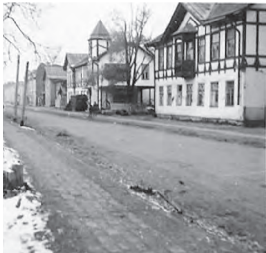
Начало Конюшенной улицы. По правую сторону улицы (справа налево): лицевые дома Е. Я. Евдокимовой (каменный двухэтажный) и «Дом с башенкой». Зима 1941/42 г.
