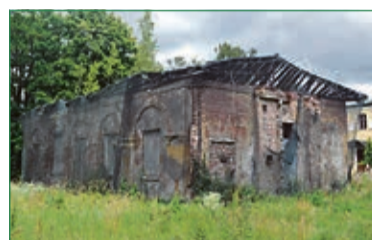
Госпитальная ул., д. 2/19
